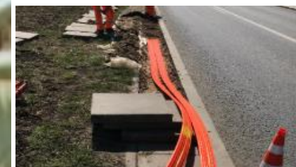
Строительство лкс тмк под придорожной плитой
